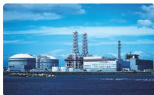
新仙台火力発電所3号系列は、CO2の排出が少ないLNGを燃料としたコンバインドサイクル発電方式を採用しています。最新鋭技術を導入し、世界最高水準となる熱効率60%超を達成しています。
