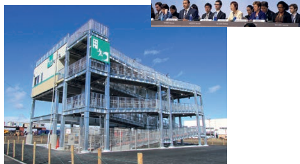
津波避難タワー
